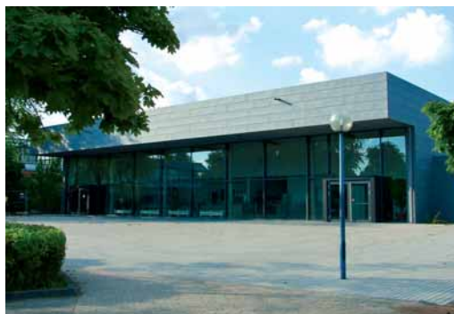
Mensa im Schulzentrum
