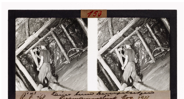
Hauer beim Setzen von Holzstempeln in halbsteiler Lagerung, 1933 (montan.dok 120160015301)
