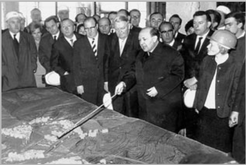
Auch die Bundesregierung misst dem Aufbau der RUB große Bedeutung bei: Ende April 1965 besucht Kanzler Erhard Baustelle und Planungsbüro
