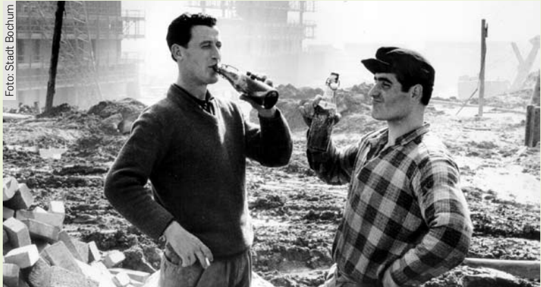
Ein Prost auf die RUB! Ein paar Jahre später auf der Baustelle.
