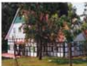
Sanierung eines Fachwerkhouses
