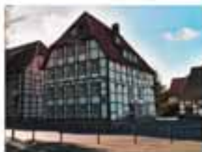
Sanierung des Labordiensthauses Ausgezeichnet mit der Pöppelmann Medaille
