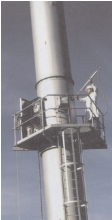
Abgasmessung an einem Industriekamin.
