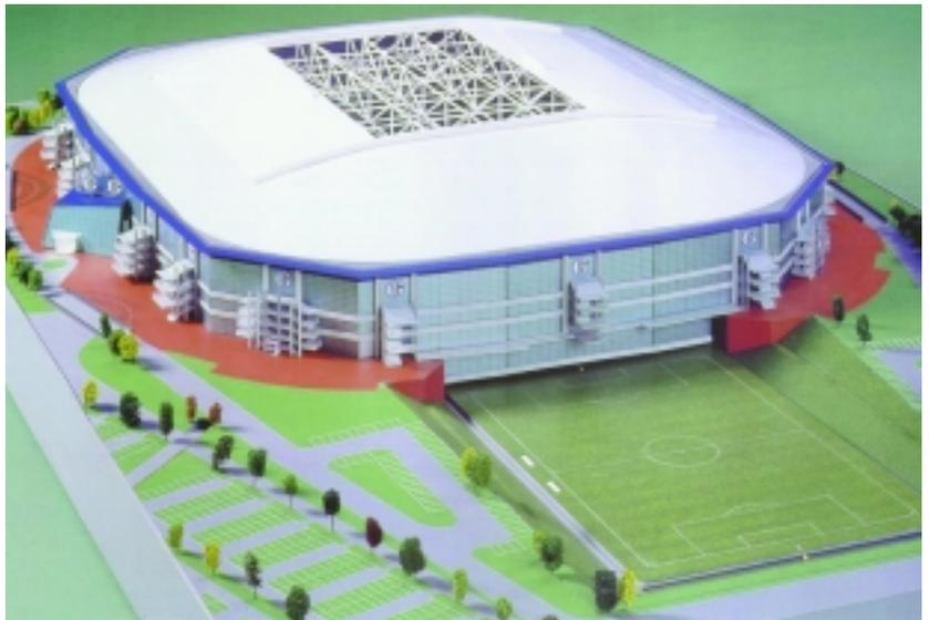
*Das Stadion der Zukunft: Die Arena AufSchalke mit verschließbarem Dach und herausfahrbarer Rasenfläche.*
