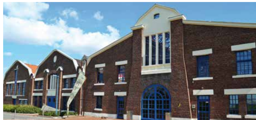
In letzter Sekunde wurde das fünfgeschiffige Gebäude der Flottmann-Werke vor dem Abriss bewahrt und unter Denkmalschutz gestellt.
