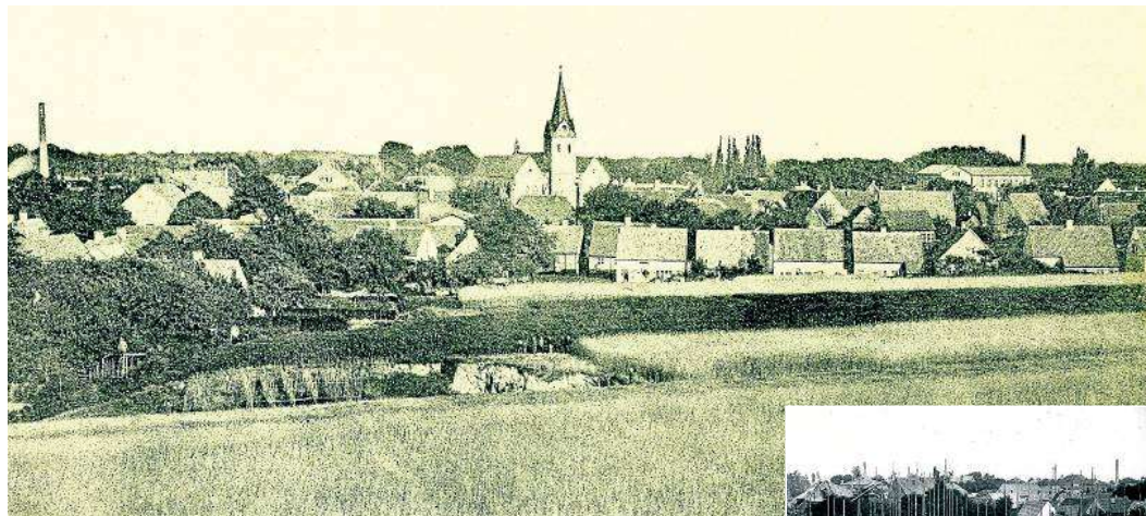
Blick auf das Dorf im Jahr 1864 (Bild oben). Auf dem Platz im Vordergrund wurde 1922 die Herz-Jesu-Kirche errichtet. Das Bild rechts zeigt die Grundsteinlegung am 13. August 1922.
