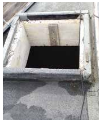
Die 60 x 60 cm große Deckenöffnung war das »Nadelöhr«, durch das alles Material hinaufgeschafft werden musste.
