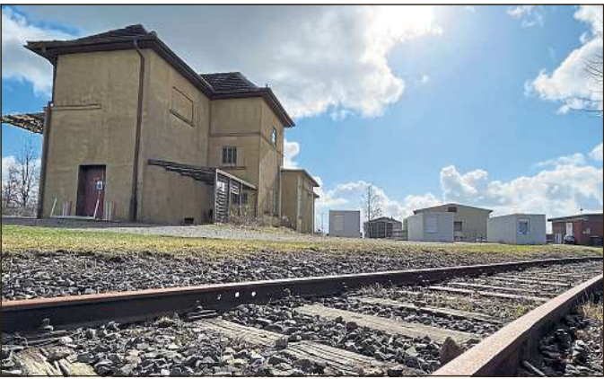
An der Neubeckumer Straße in Ennigerloh sollen entlang der Bahntrasse auf dem Gelände des alten Bahnhof Kalköfen eine Containeranlage errichtet werden. Foto: tiju
