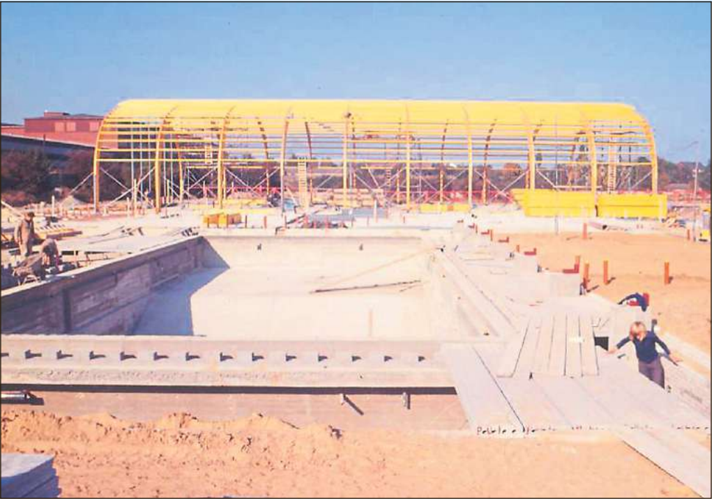
Am 3. Mai 1972 erfolgte der erste Spatenstich für das Ennigerloher Olympiabad. Gut ein Jahr später, am 13. April 1973, wurde das Hallenbad der Öffentlichkeit übergeben. Fotos: Stadt Ennigerloh
