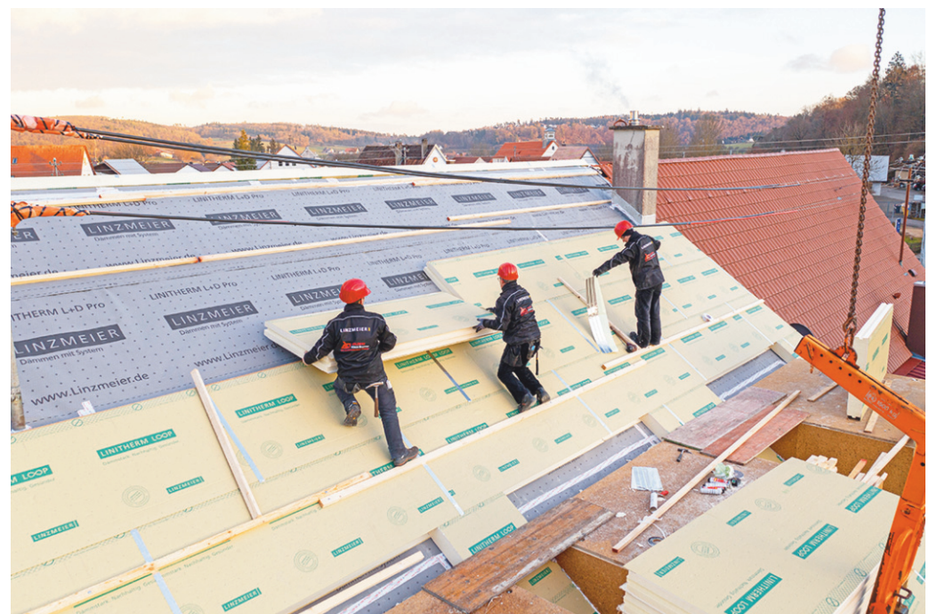
Eine Aufsparrendämmung wird auf dem Dach montiert. Foto: djd/Linzmeier Bauelemente
