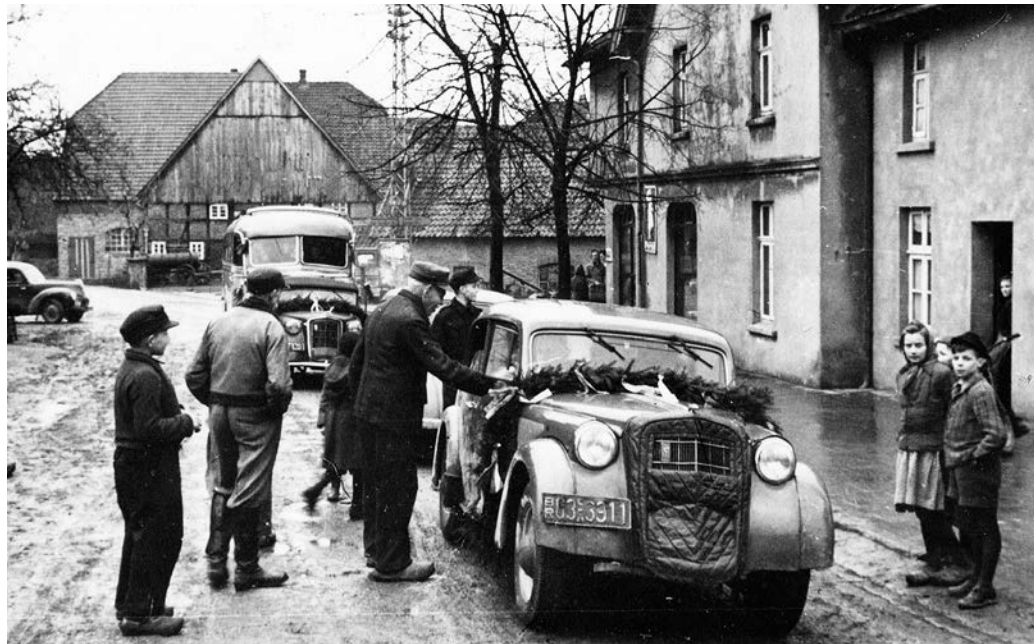
1951: Hochzeitsfahrzeuge mit Kennzeichen der britischen Besatzungszone auf der Hagenschen Straße. Über die Hochzeit ist nichts bekannt. Die interessiert zuschauenden Mädchen tragen Kopftuch, die Jungen Mütze und alle gemeinsam Holzschuhe oder Gummistiefel. Die Liemer Straße beginnt hinter dem Haus auf der rechten Seite (= Hausstätte Nr. 19 / Hagensche Str. 184; ehemalige Bäckerei August Beermann). Im Hintergrund die Hofstätte Nr. 10 Stüker (Liemer Straße 15). Foto: E. Schröder
