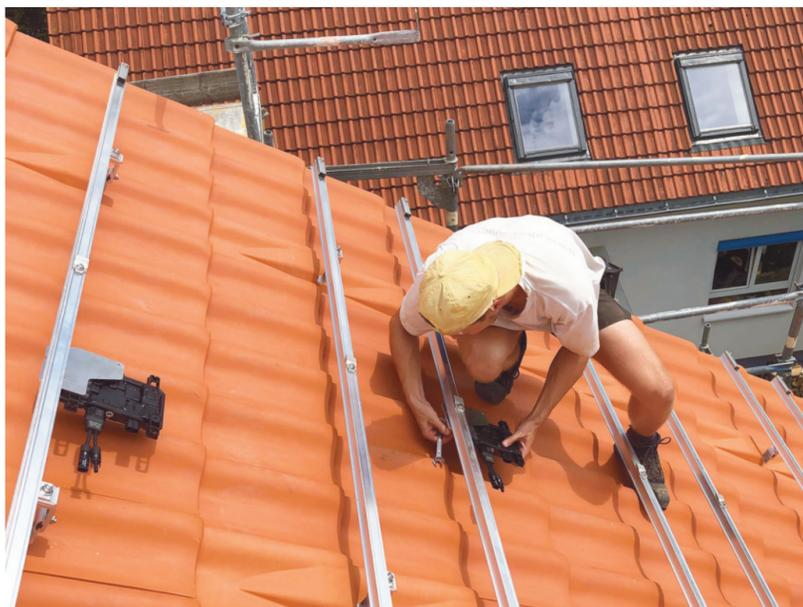
Dezentrale Lösung: Jeder Mikrowechselrichter ist nur mit einem einzigen Photovoltaik-Modul verbunden.
