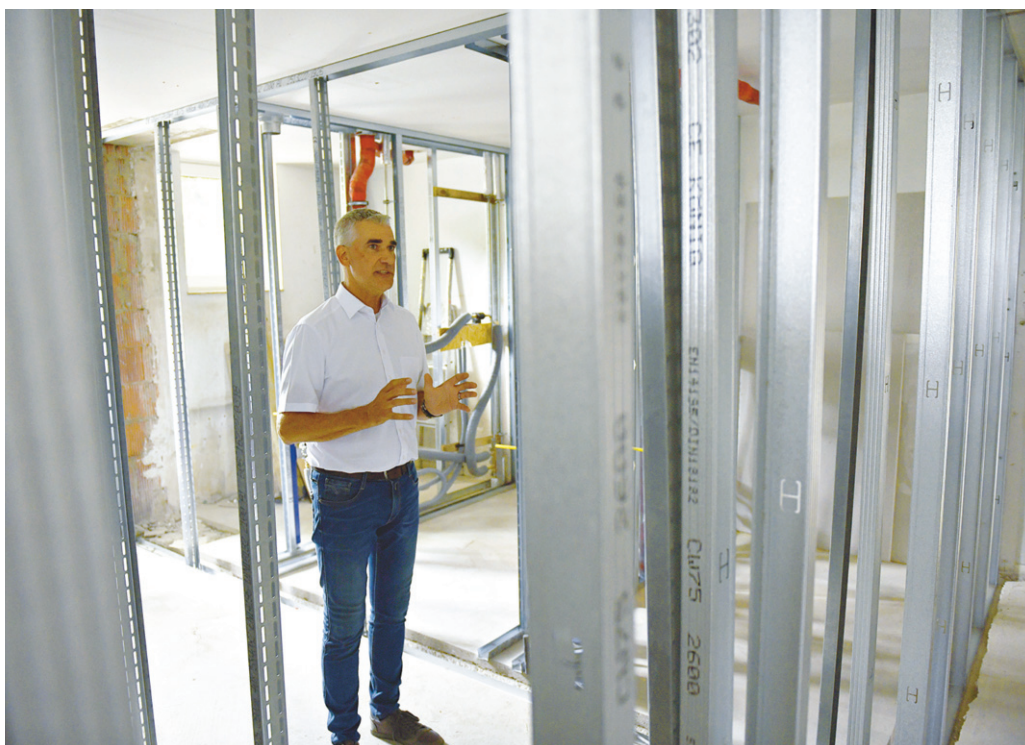
Beigeordneter Thorsten Paulussen erklärt die Sanierungsmaßnahmen in der Bredestraße. Foto: rp
