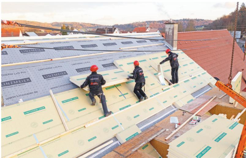
Eine Aufsparrendämmung wird auf dem Dach montiert.
