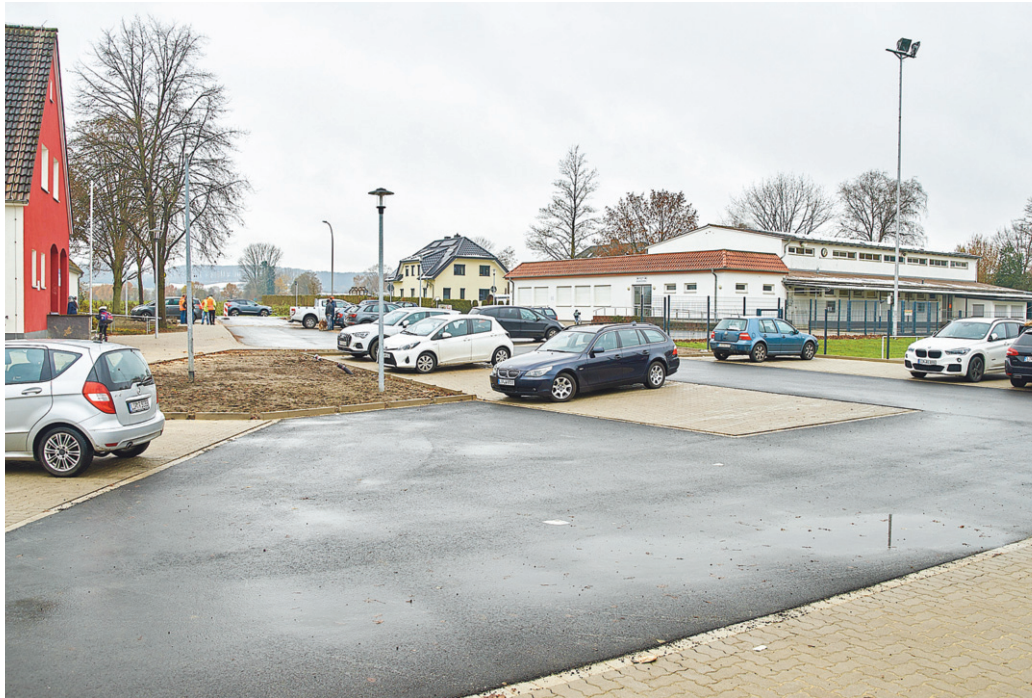
Auf dieser neu angelegten Fläche am Kleinspielfeld wurden gut 25 Pkw-Stellplätze geschaffen. Die Fläche ist ausreichend groß für das alljährliche „Tanz in den Mai“-Festzelt.
