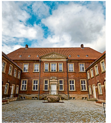
Der Vorplatz der Landsbergschen Kurie an der Pferdégasse ist fertiggestellt, die letzten Arbeiten im Inneren des Museums schreiten voran. Foto: WWU/bhe
