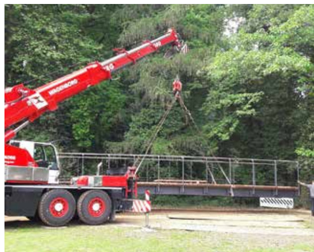
Anlieferung der neuen Brücke
