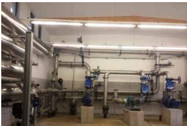
Faulschlamm-Umwälzung
