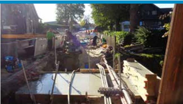
Am 05.09.2018 beginnen an der Schulstraße Arbeiten zur Erneuerung eines Teiles der Verrohrung des Bruchbaches. Die derzeitige Verrohrung besteht unterhalb des Gehweges aus Mauerwerk, dessen Standicherheit erheblich eingeschränkt ist. In der Vergangenheit musste die Anlage bereits mehrfach notdürftig repariert werden.
