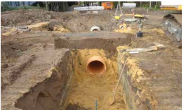
Verlegung Regenwasserkanal
