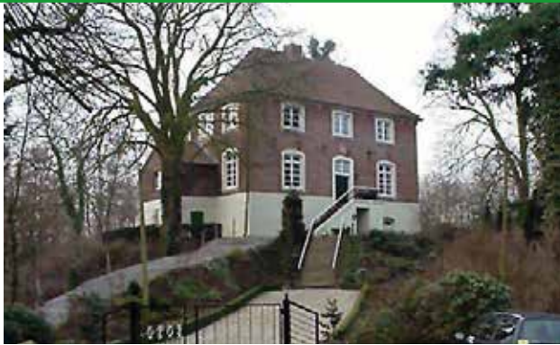
„Haus Döring“, Urkundlich zuerst 1291 erwähnt, 1727 auf alten Fundamenten erneut errichtet.
