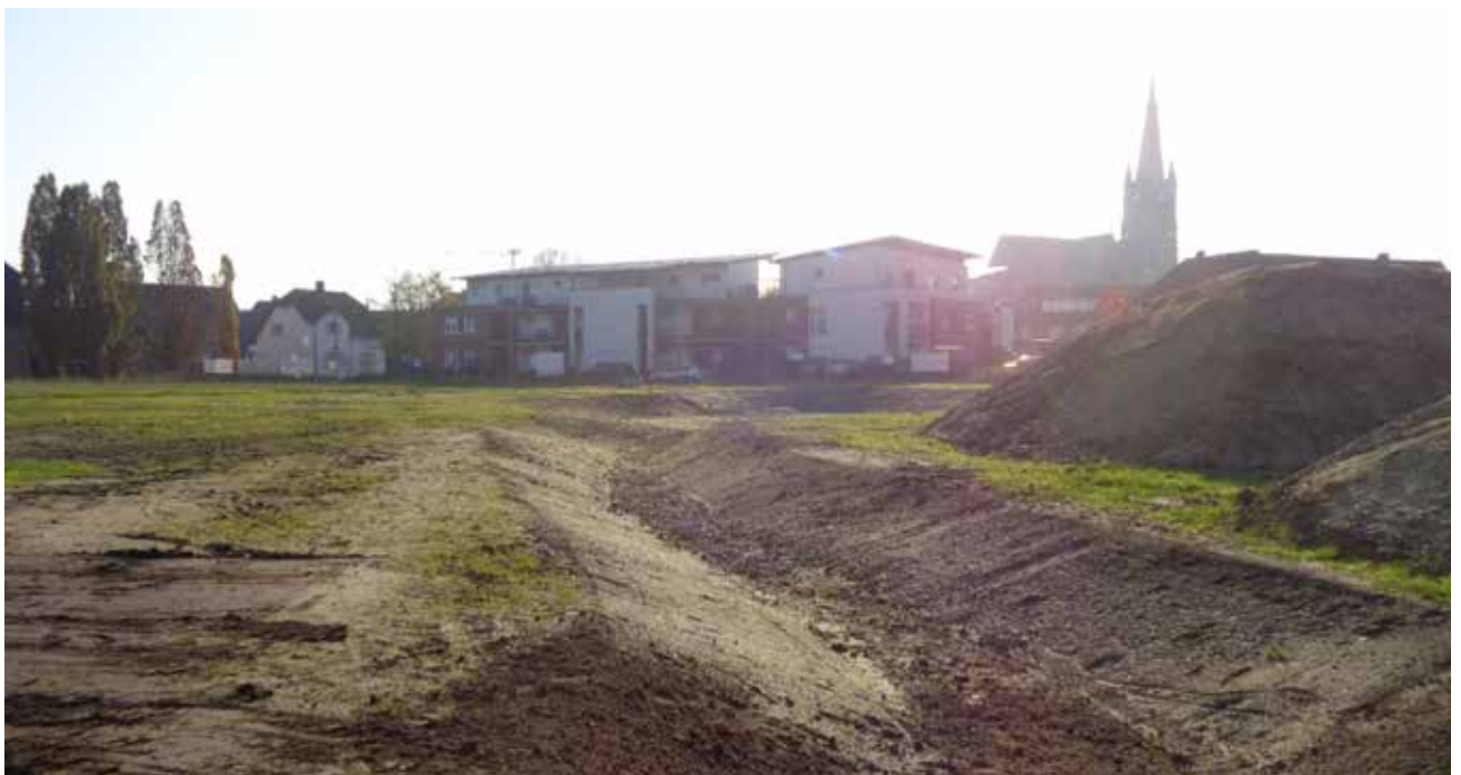
Erstellung Versickerungsmulde
