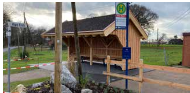
Fertiggestellte Schutzhütte Kips Esch/Große Heide mit Gründach, Foto: Stadt Borken, Dezember 2020
