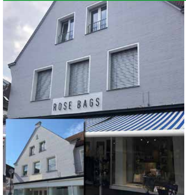
Erneuerung der Fassade des Gebäudes Markt 10, Borken. Das Bild links unten zeigt den Zustand vor der Sanierung. Quelle: privat und Stadt Borken, Fachabteilung Umwelt und Planung
