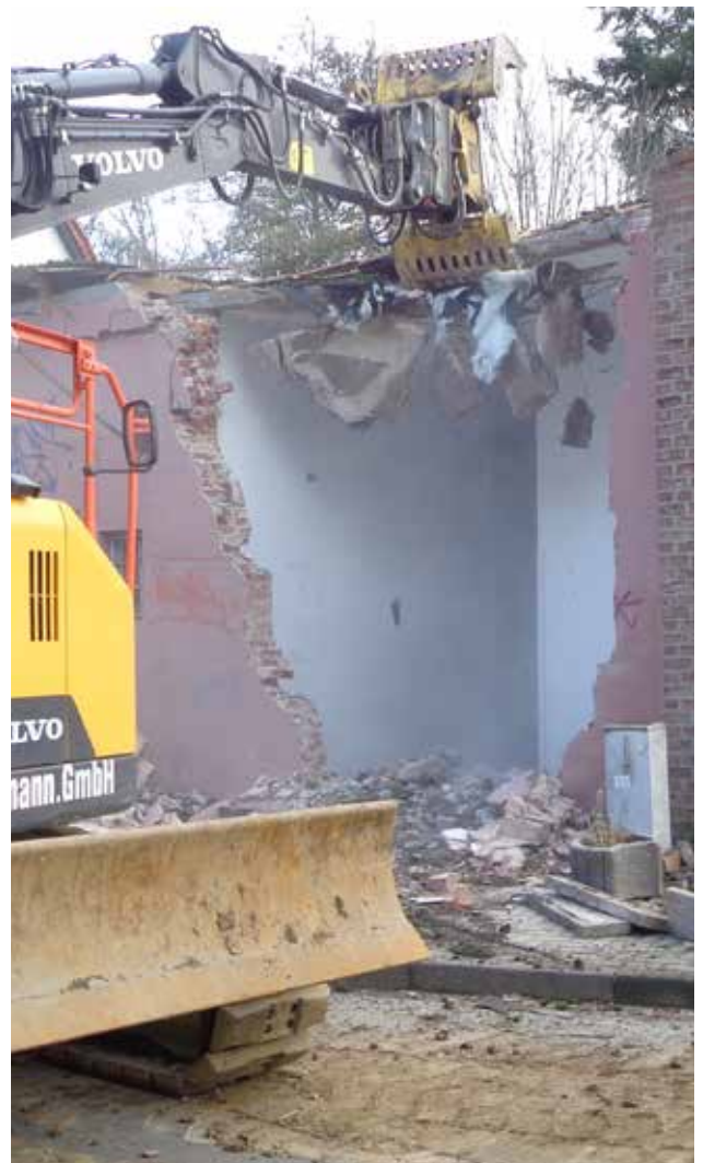
Abriss Trafohäuschen Mühlenstraße
