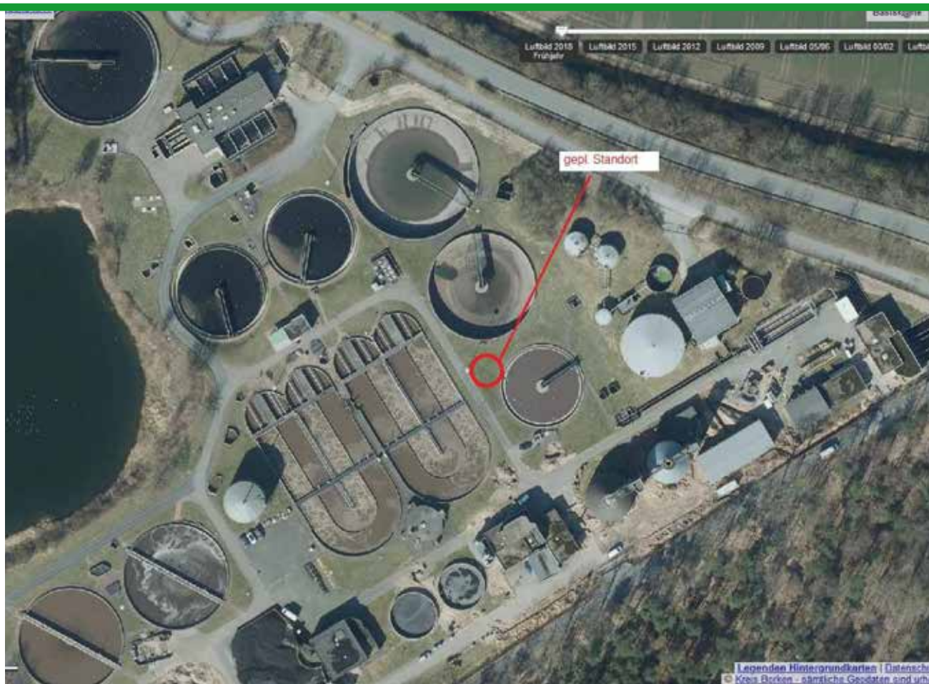
Luftbild der Kläranlage mit dem geplanten Standort für die S::Select-Anlage
