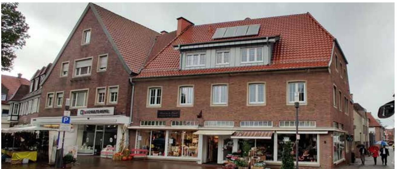
Mühlenstraße 5 nach der energetischen Sanierung mit Zuschuss aus dem Fassadenprogramm der Stadt Borken
