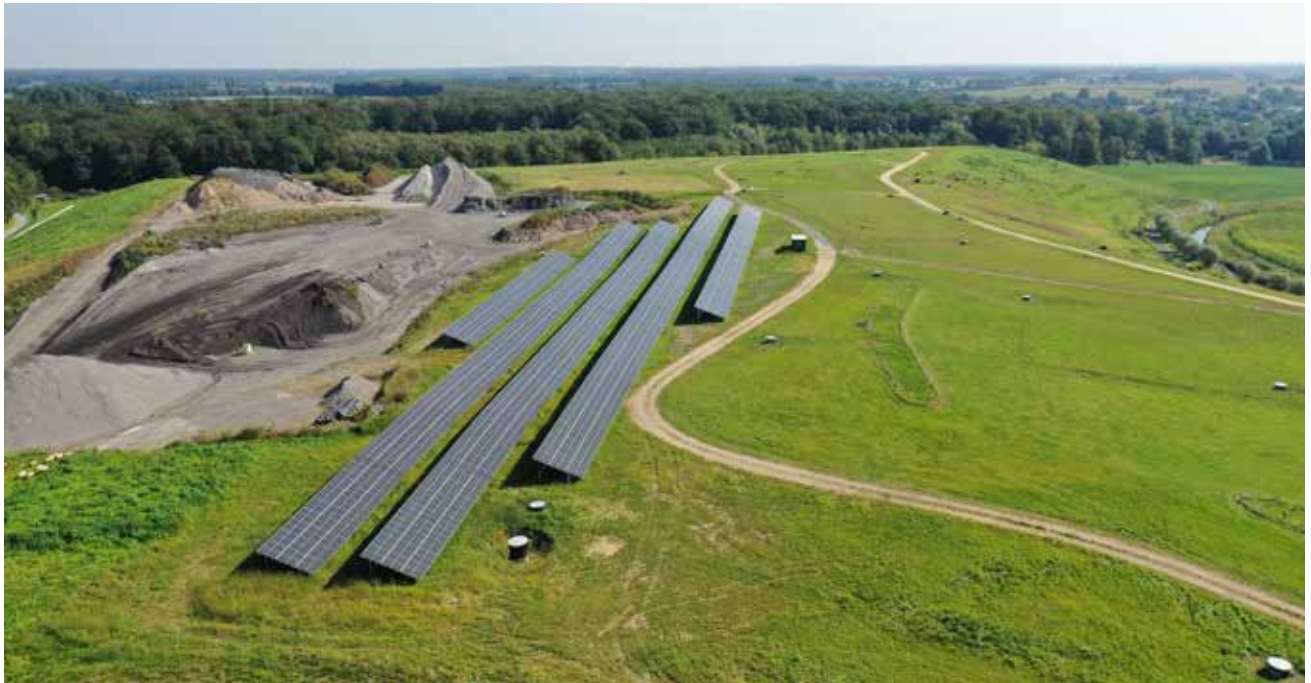
Luftbild der Photovoltaik-Anlage in Borken Hoxfeld auf der ehemaligen Deponie. (Foto von EGW)
