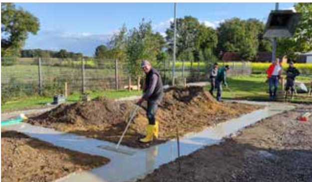
Die Bauarbeiten beginnen: Eine Schirmschoppe entsteht durch den Bürgerschützenverein in Borken-Burlo.
