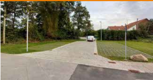
An der Jodocus-Nünning-Gesamtschule sind 33 neue Parkplätze geschaffen worden.
