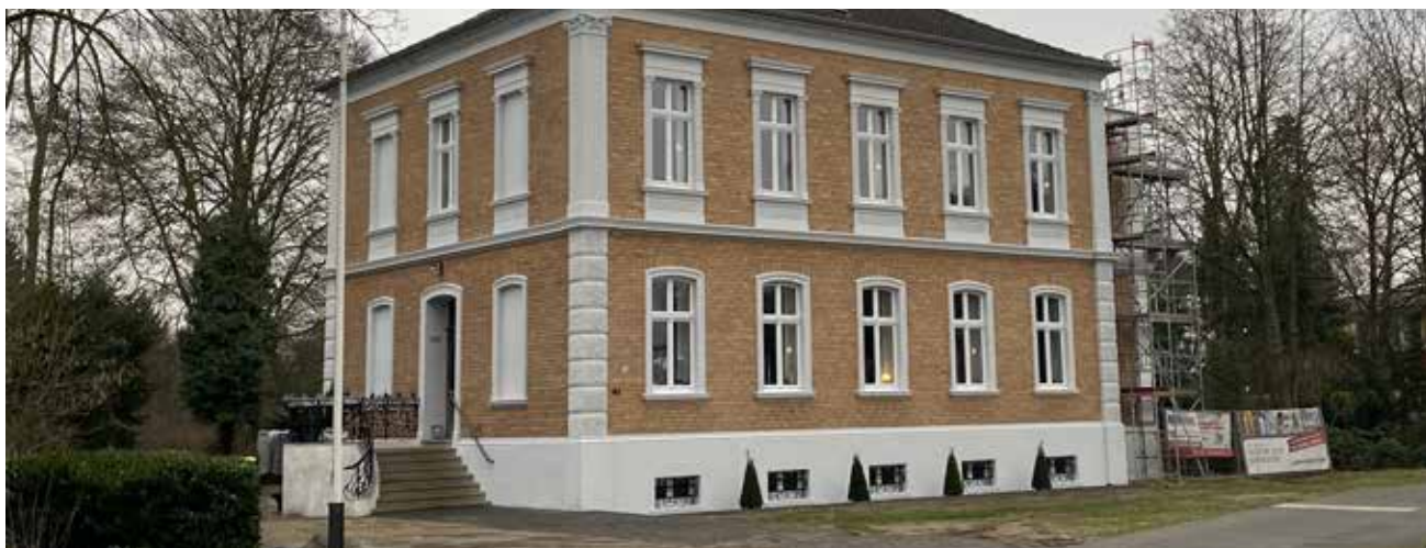
Die Villa Grüter nach der fast abgeschlossenen Sanierung.
