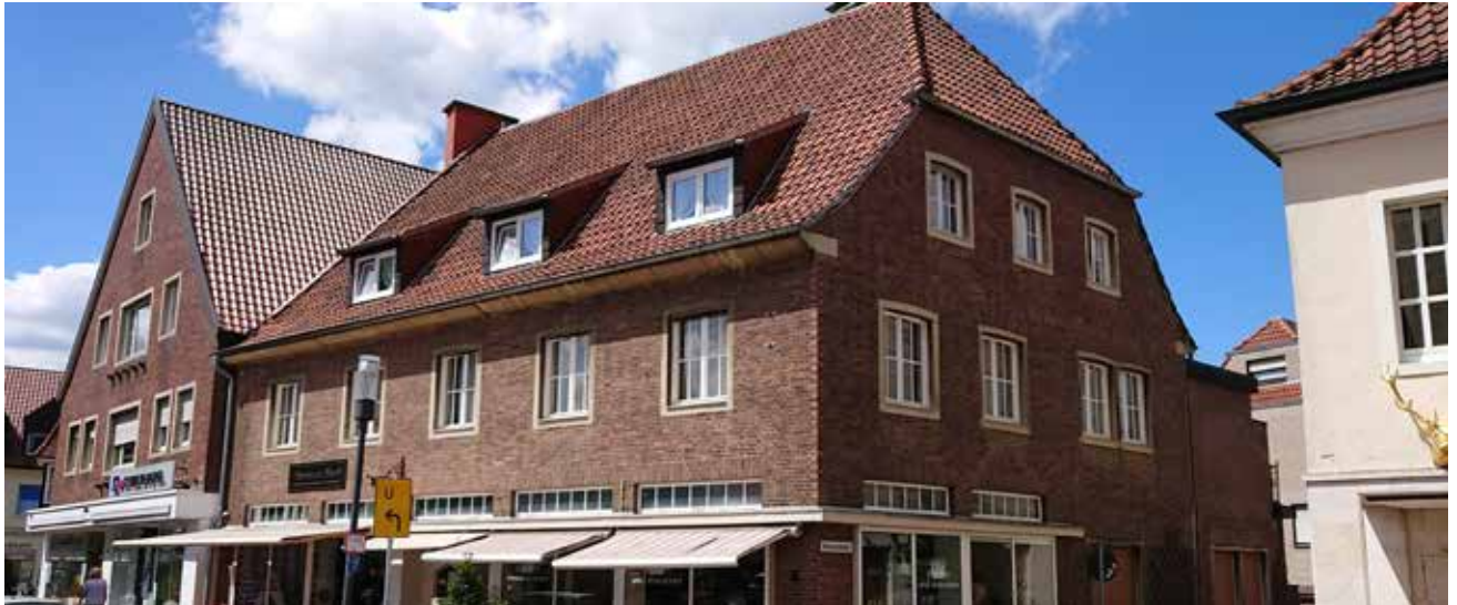
Mühlenstraße 5 vor der Sanierung
