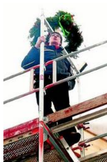
Der Richtkranz ist befestigt.
