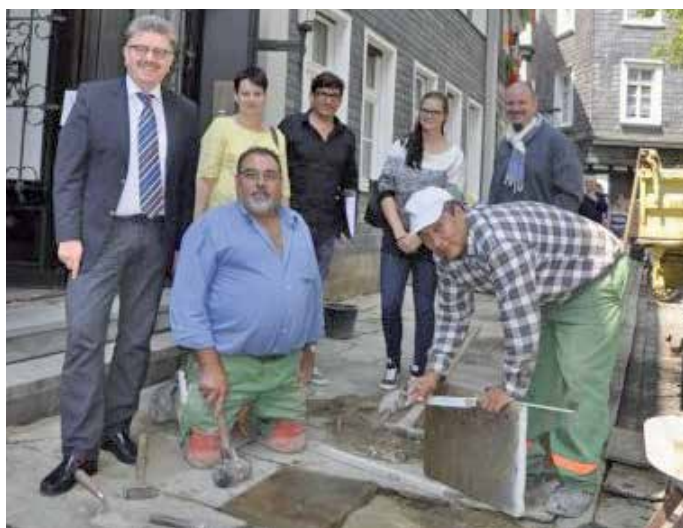
Vertreter der ev. St. Georgs Gemeinde und der Stadt bei den Pflasterarbeiten am Kirchplatz
