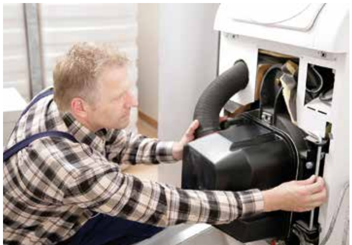
Bei der Heizungswartung reinigt der Fachmann Kessel und Brenner, tauscht Verschleißteile aus, überprüft die Einstellungen und entlüftet die Anlage. Dadurch wird eine gleichmäßige Verbrennung und somit die optimale Ausnutzung des Brennstoffs gewährleistet. Bilder: bpr/IWO
