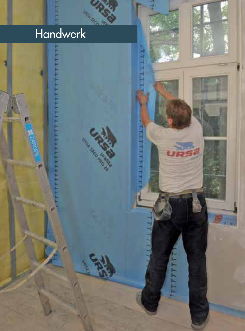
Wärmedämmung senkt die Energiekosten und beugt Schimmelbildung vor. Wenn die Fassade des Eigenheims nicht von außen gedämmt werden kann, empfehlen sich speziell entwickelte Mineralwolle-Systeme für die Innenseite der Außenwände. Foto: Ursa/txn-p
