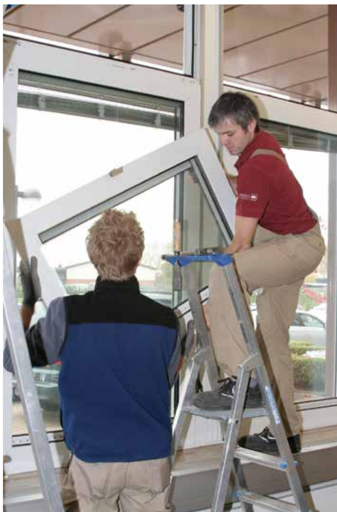
txn-p. Der Austausch veralteter Fenster macht längst nicht so viel Schmutz, wie viele befürchten. Die Wirkung hingegen ist enorm: Hochwertige Kunststoffprofile der Klasse A mit innovativem Mehrkammersystem verbessern nachhaltig den Schall- und Kälteschutz.
