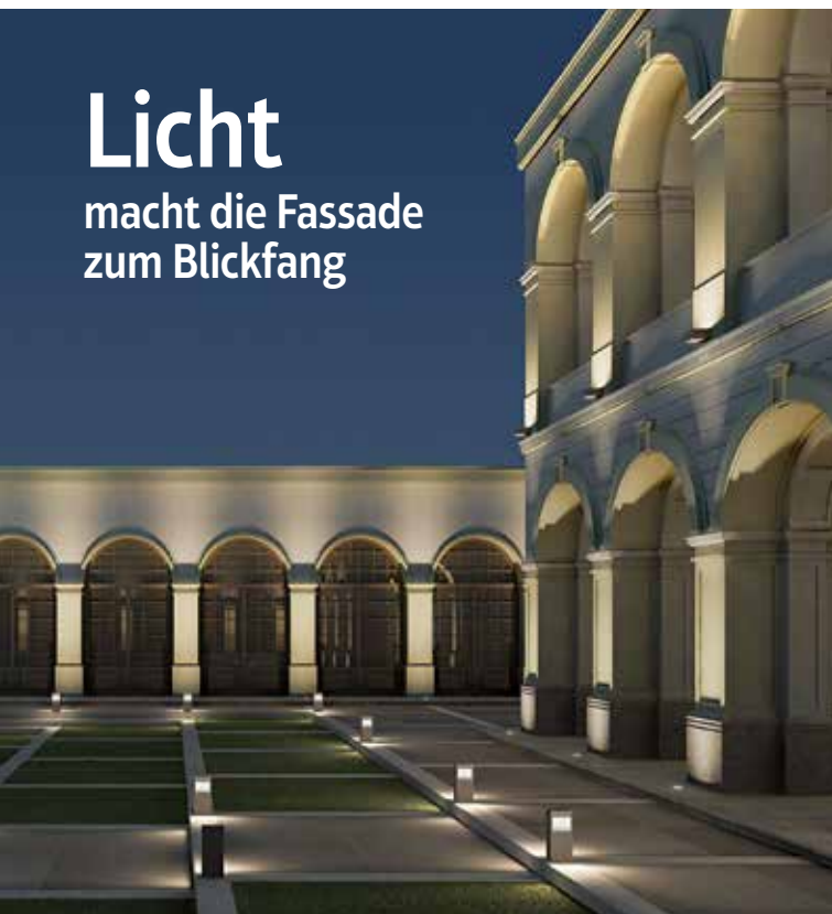
Gebäudenah installierte Leuchten betonen Details der Fassaden, zum Beispiel Fensterlaibungen oder historische Gesimse. Foto: licht.de
