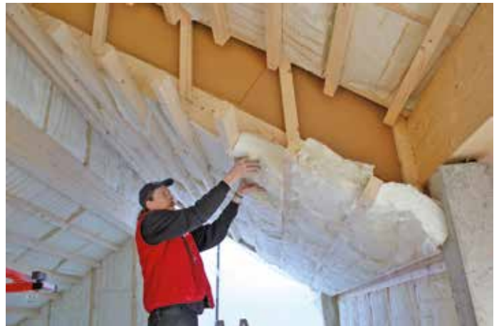
Neubauten müssen laut Energieeinsparverordnung ab 2016 noch besser gedämmt werden. Hochwertige Mineralwolle hilft dabei, dass weniger Wärme verloren geht, der Energiebedarf sinkt und die Umwelt geschont wird. Foto: Ursa/txn
