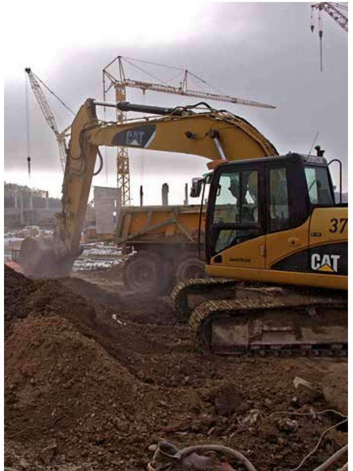
Gleich bei zwei Gerichten liegen Klagen gegen den Neubau am Autobahnkreuz Nord in Wuppertal an der Stadtgrenze zu Sprockhövel vor. Foto: Schletter
