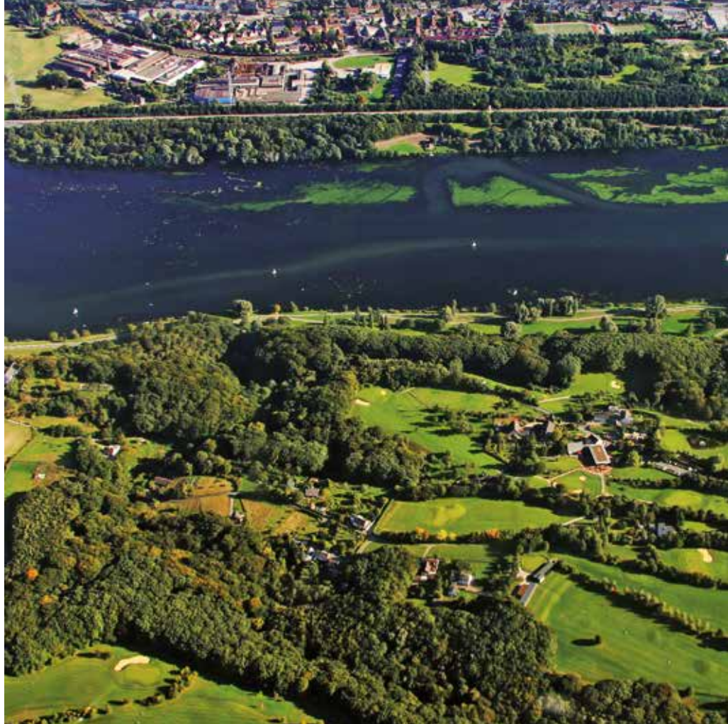
Als bisher letzte Staustufe im Ruhrlauf wurde im Jahr 1979 der Kemnader See festgestellt. Er ist Freizeitzentrum und dient der Reinigungswasser.
