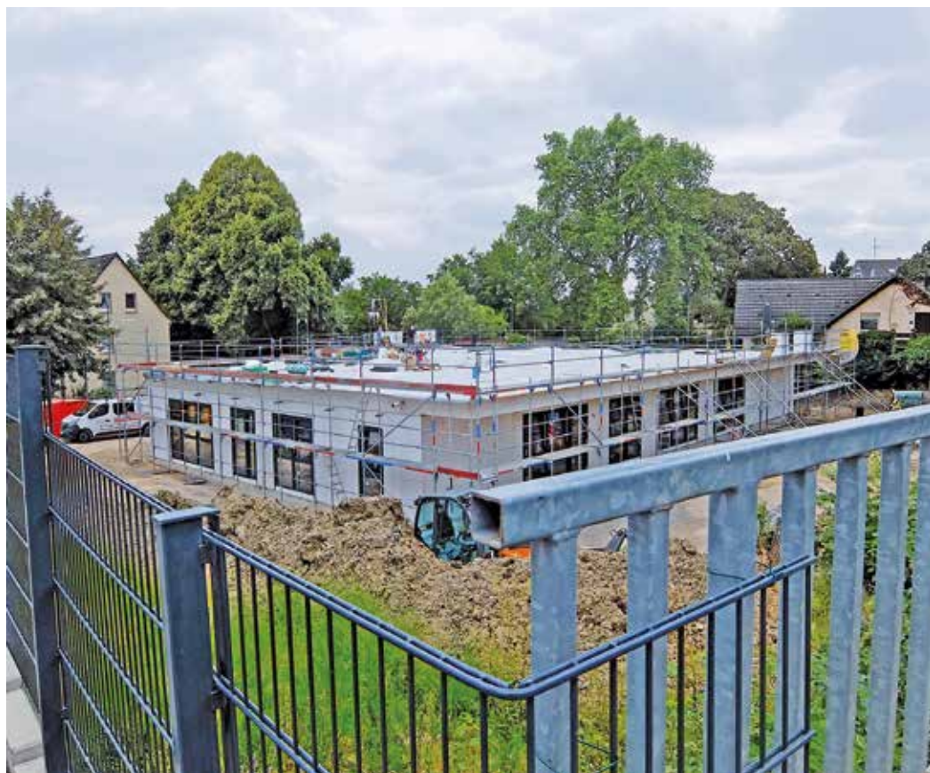
Der Neubau ist in Kooperation mit der Wohnungsgenossenschaft „Gartenstadt Hüttenau“ entstanden.
