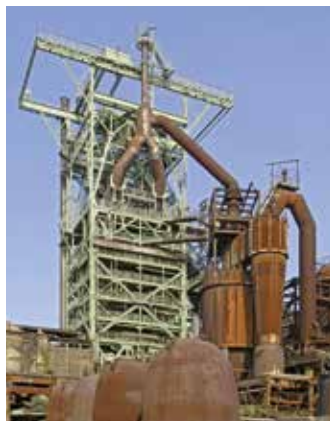
Die Arbeiten am Hochofen gehen voran.
