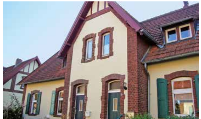
Die Zechensiedlung Müsendrei der ehemaligen Spateisensteinezeche Müsen III stellt das charakteristische Bild einer werksgebundenen Arbeitersiedlung der Jahrhundertwende dar. Die Siedlung wurde im Jahre 1907 errichtet. Im Mittelpunkt der Zechensiedlung stand bis 1975 auf der jetzigen Freifläche das Schachtgebäude mit integriertem Förderturm. Die Zeche war der Henrichshütte angegliedert. Durch die Typisierung der Bauten und die strenge symmetrische Anordnung als Doppelhäuser oder Dreierblocks ist ein in sich geschlossenes Siedlungsbild entstanden, bei dem der öffentliche Straßenraum durch die Gebäude und Vorgärten geprägt und gefasst wird. Dieses Bild soll in jedem Fall erhalten bleiben. Foto: Pielorz
