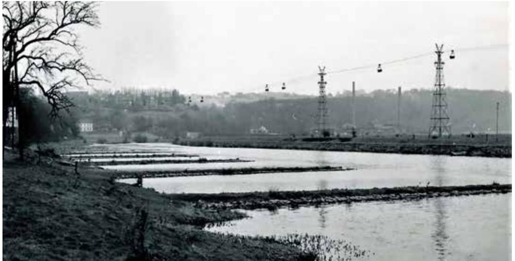
Die Seilbahn „Friedlicher Nachbar“ aus dem Zechengebiet in Bochum-Linden führte zur Henrichshütte. Die Drahtseilbahn wurde 1922 in Betrieb genommen und führte durch das Rauendahl über die Ruhr zur Henrichshütte. 1961 wurde die Zeche geschlossen und die Seilbahn überflüssig. Das Bild stammt aus dem Jahr 1959. Foto: Stadtarchiv Hattingen
