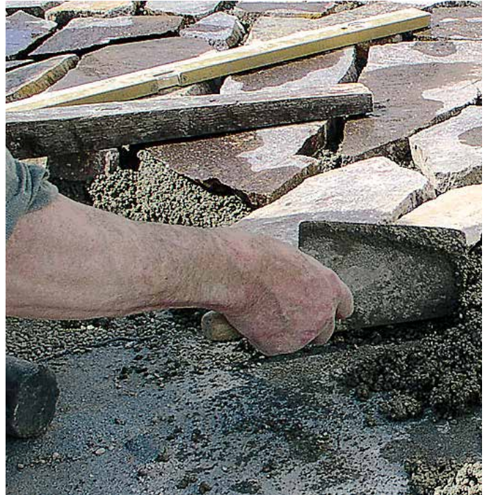
Auf die Grundlage kommt es an: Natur- oder Kunststeinplatten lassen sich mit dem richtigen Mörtel auch selbst verlegen. Foto: Saint-Gobain Weber/txn
