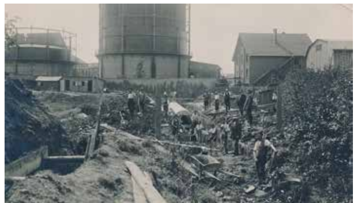
Die Gasöfen der Stadtwerke.
