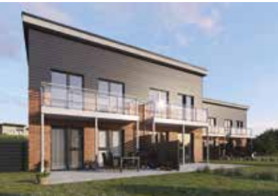
Eine Fassadenbekleidung mit Faserzement-Elementen setzt individuelle Akzente, wirkt sehr edel, bietet Schutz für Jahrzehnte und sieht dabei richtig gut aus. Foto: Hundven-Clements Photography/txn
