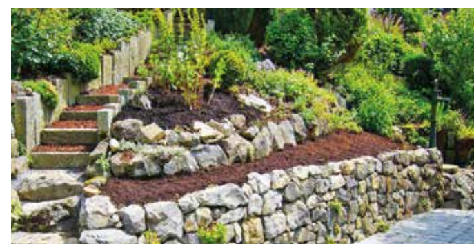
Abgefangene steile Böschung
