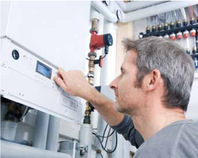
txn-p. Moderne Gas-Brennwert-Geräte stellen sich automatisch auf die Jahreszeit ein. Bei älteren Geräten sollte in der warmen Jahreszeit per Hand auf Sommerbetrieb umgeschaltet werden. Dadurch wird die Umwälzpumpe abgeschaltet, was viel Strom spart. Die Warmwasserversorgung ist dennoch gewährleistet. Foto: Zukunft Erdgas e.V./txn-p
