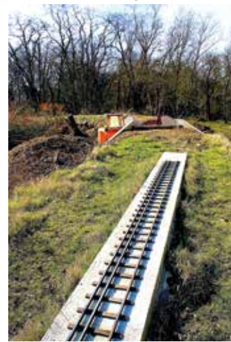
Auf die Gleise: Im Hintergrund stehen schon die Fundamente für die Brücke
