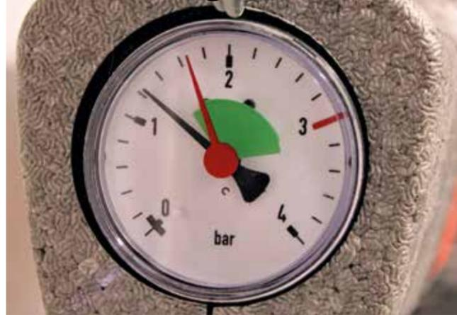
Ein Manometer misst den Wasserdruck und zeigt an, wann wieder Wasser nachgefüllt werden muss. Unter einem Bar sollte der Druck nicht sinken, sagen die Experten. Entscheidend ist aber auch der Höhenunterschied zwischen Manometer und Heizungshöhe. Foto: Pielorz
