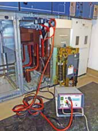
Wartung in einer Trafostation
