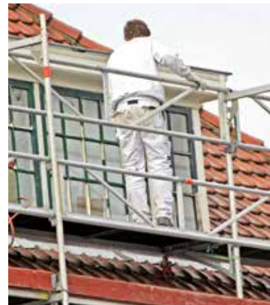
Die Dachpfannen als äußerste Schicht sollten natürlich intakt sein. Wichtiger ist jedoch, dass die darunter liegende Unterdeckbahn zuverlässig Wind und Regen fernhält und gleichzeitig diffusionsoffen ist.
