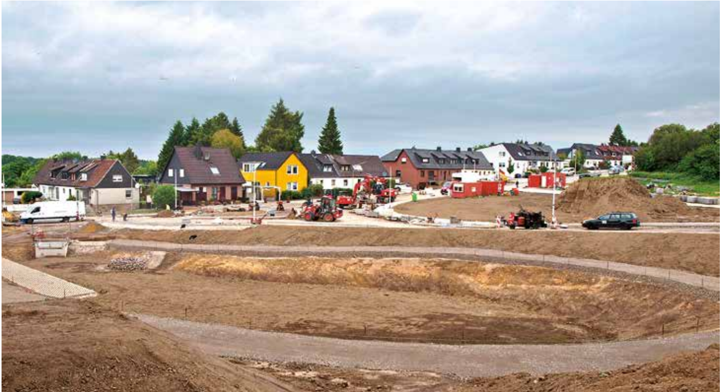
2014 wurde im Auftrag der Stadt Witten mit dem Bau der verschiedenen Erschließungsmaßnahmen begonnen, sodass im Herbst dieses Jahres die privaten Baumaßnahmen beginnen können.
