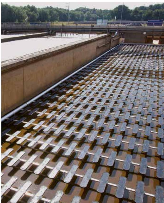
Die neue Belüftung in den Becken der Kläranlage Ölbachtal. Der Ruhrverband ist Träger der Wasserwirtschaft im gesamten Flussgebiet der Ruhr mit einem System von Talsperren zur Bewirtschaftung der Wassermengen und einem Netzwerk von Abwasserbehandlungsanlagen zur Reinhaltung der Gewässer für 60 Kommunen. Foto: Ruhrverband
