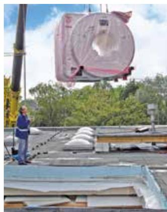
Maßarbeit mit schwerem Gerät: Ein 160 Tonnen schwerer Autokran hat einen neuen Magnetresonanztomographen (MRT) durch eine Öffnung im Flachdach des Funktionstraktes in die Räume der Radiologischen Praxis im Evangelischen Krankenhaus Witten gehievt.
