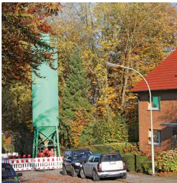
Im Zuge der Sicherheitsarbeiten werden die Hohlräume und Verbruchzonen mit einem flüssigen Beton verfüllt. Diese Arbeiten dauern mindestens 10 Wochen.
